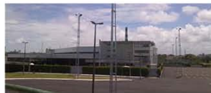
Obras Cecon – requalificação do estacionamento interno no Cecon
