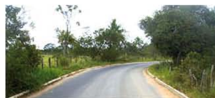
Estrada da Mumbeca – implantação de aproximadamente 14 km
