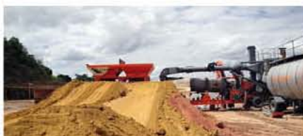
PE-96 – revestimento e drenagem de 10 km da via
