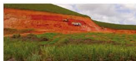
MCE – terraplenagem da área para implantação de indústria
