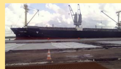
Trabalho de ampliação do local é realizado pela Lidermac Construções
